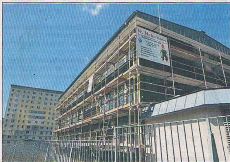
Von außen hat das Feuerwehrgebäude in der Aue II vergangenes Jahr ein neues Gesicht bekommen. Nun stehen weitere dringende Sanierungen im Inneren an. Dafür soll eine Prioritätenliste erarbeitet werden. Foto: Archiv/frankphoto.de
